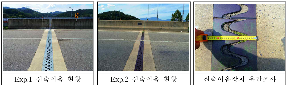
【그림 3.20】 신축이음장치 현황 및 외관조사
