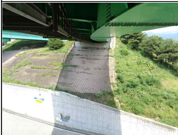
거더외부 외관조사(교량점검차, 도보)
