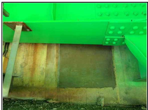
교대 균열보수 전경
