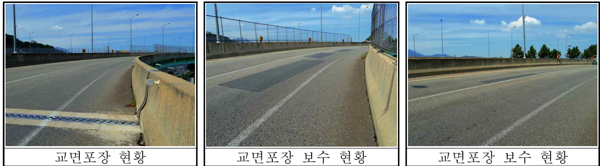
【그림 3.3】 교면포장 현황
