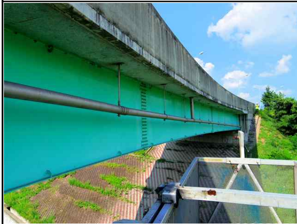
배수관 외관조사(교량점검차, 도보)
