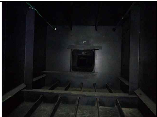
거더 내부 외관조사(도보)
